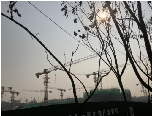
松柏安置小区（厂区西南侧约 750m，在建）
