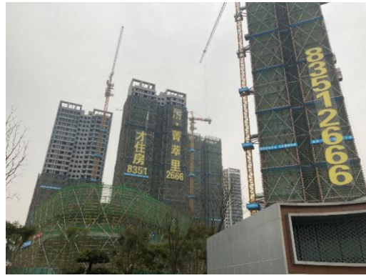
人才公寓 1 期 天府菁萃里（厂区东南侧约 1540m，在建）
